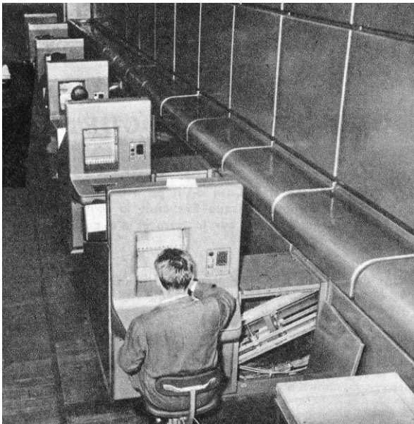
Hotchkiss-Brandt 300 D direct sorter at Paris 1, rue du Louvre
